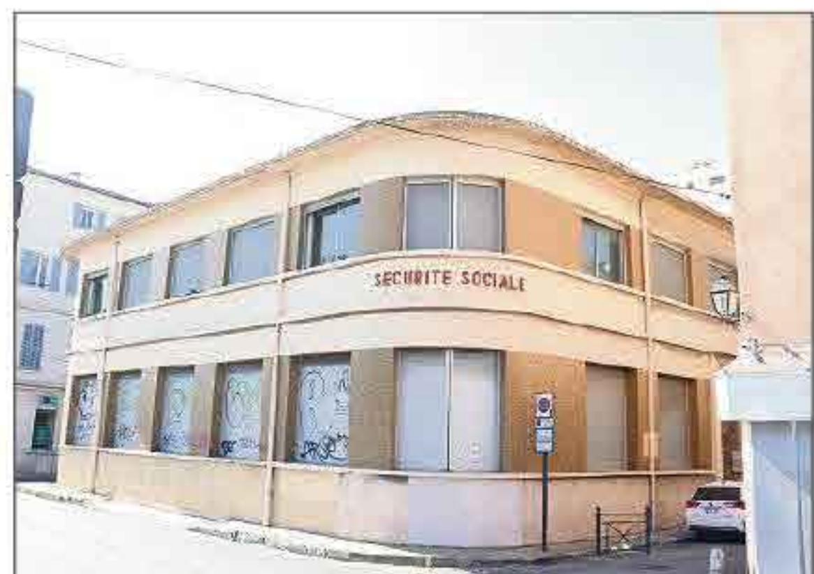
L'ancien bâtiment de la CPAM est vide depuis 2000.
